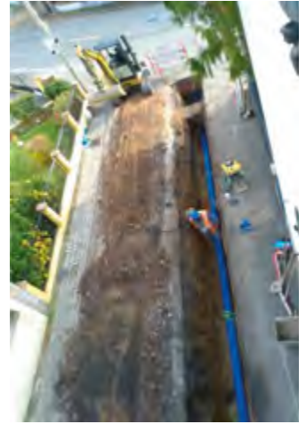
Pose de la nouvelle conduite
