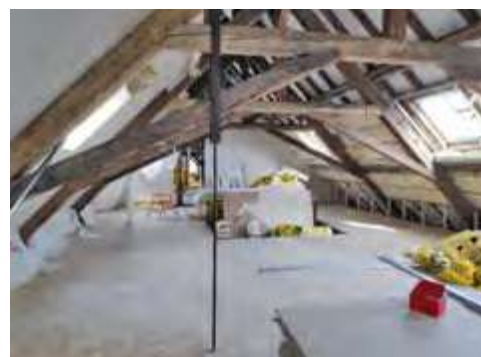
Pose des plaques de plâtre par-dessus l'isolation
