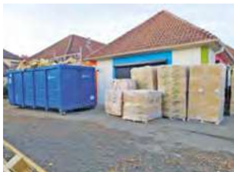
Dépose de l'ancienne isolation dans la benne, stockage de la nouvelle isolation dans la cour (avant travaux).
