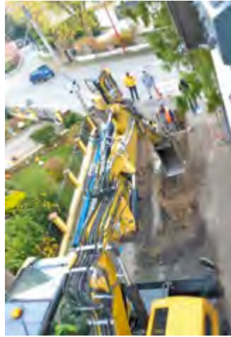
Excavation de la terre
