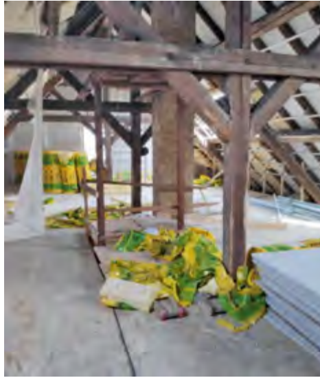
Pose des supports pour l'isolation laine de verre double couche et support pour les plaques de placoplatre
