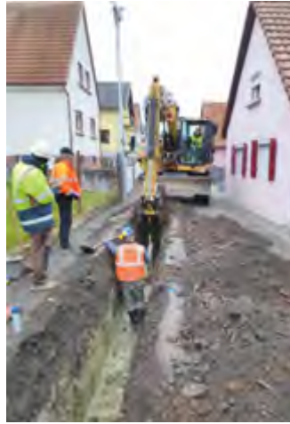
Préparation pour la pose de la nouvelle conduite
