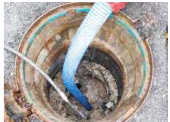
Résidus gras incrustés dans le fond du séparateur avant nettoyage
