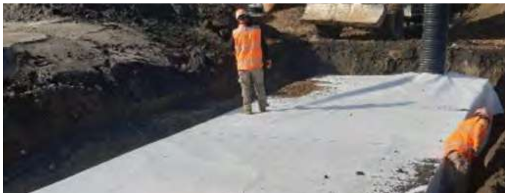
Photos d'illustration des caisses ainsi que de la bâche lors de la mise en place d'une noue. Il ne s'agit pas de photos de la noue du Murbruch mais de clichés provenant d'un autre chantier
