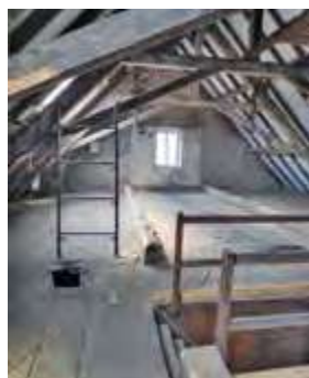
Traitement contre le capricorne (ver à bois)
