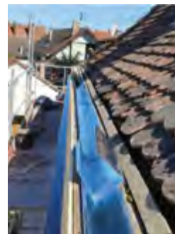
Chéneaux en cours de travaux et de pose
