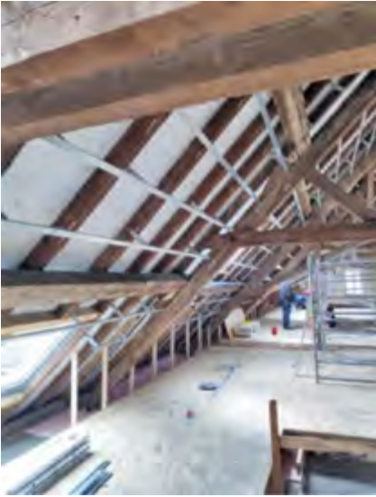
Pose des supports pour l'isolation laine de verre double couche et support pour les plaques de placoplatre
