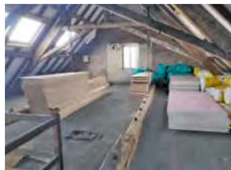
Entreposage du matériel nécessaire : isolation, placo-plâtre coupe-feu, plaque OSB
