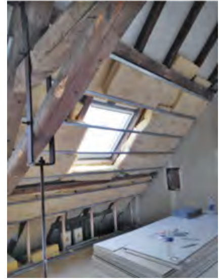
Pose des supports pour l'isolation laine de verre double couche et support pour les plaques de placoplatre
