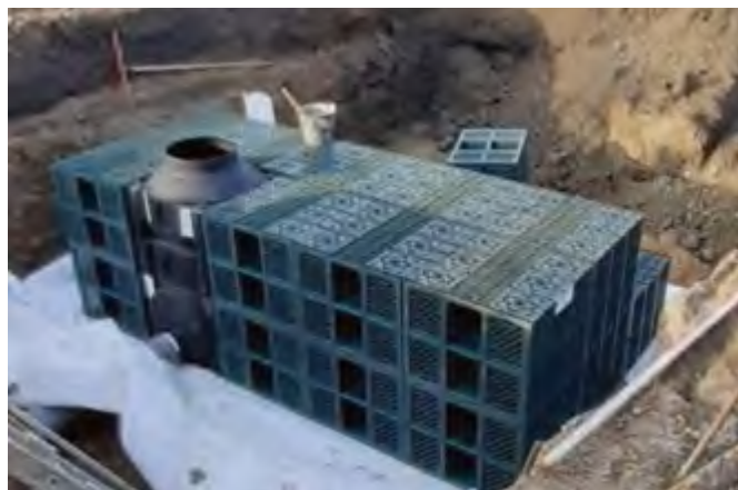
Photos d'illustration des caisses ainsi que de la bâche lors de la mise en place d'une noue. Il ne s'agit pas de photos de la noue du Murbruch mais de clichés provenant d'un autre chantier
