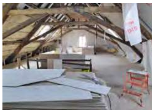
Pose des plaques de plâtre par-dessus l'isolation
