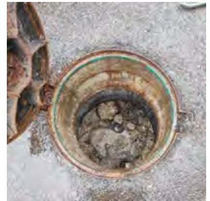
Résidus gras incrustés dans le fond du séparateur avant nettoyage
