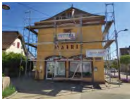
Mise en place de l'échafaudage pour la réalisation des travaux.
