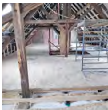
Réhausse du sol avec pose de placo-plâtre coupe-feu + isolation + nouveau sol en OSB
