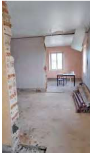
Pose des supports pour l'isolation laine de verre double couche et support pour les plaques de placoplatre
