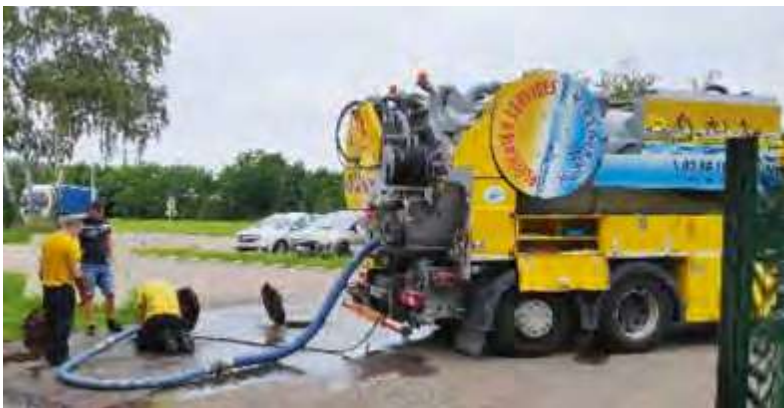
Aspiration des corps gras et des résidus présents dans le séparateur d'huile
