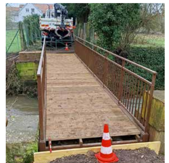
Travaux en cours
