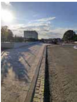
Les pavés permettent aux collégiens de circuler à pied en toute sécurité dans la rue, tout en lui donnant un air moderne. Les pavés favorisent l'infiltration de l'eau de pluie.
