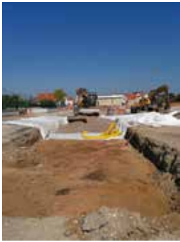
La première phase des travaux (après décaissage des enrobés) a nécessité de creuser la chaussée.
