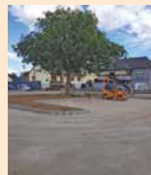
Les travaux ont nécessité de retirer le revêtement précédent et de procéder à une nouvelle mise à plat du sol avant de pouvoir continuer l'aménagement.
