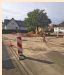
Les travaux ont nécessité de retirer le revêtement précédent et de procéder à une nouvelle mise à plat du sol avant de pouvoir continuer l'aménagement.
