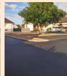
La place des Tulipes a fière allure une fois les travaux achevés.
