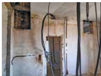
D'importants travaux de réaménagement ont dû être effectués.
