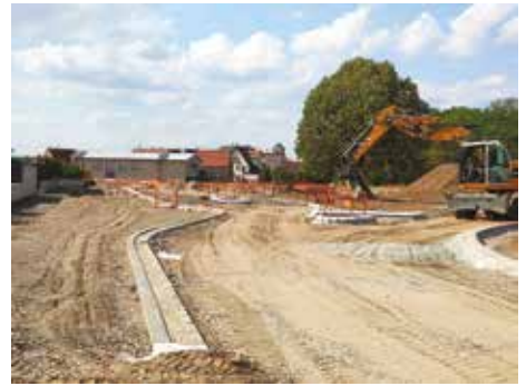
Toute la ligne de la rue Louis Pasteur a été redessinée, et des îlots ont été mis en place.
