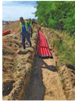
Les fourreaux pour les câbles d'alimentation des panneaux solaires et bornes de recharge pour véhicules électriques ont été placés parallèlement à la ligne SNCF.
