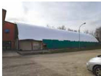
Le rattachement de la toile (blanche) au bâtiment a été complexe et a nécessité de l'ingéniosité afin de garantir son étanchéité.
