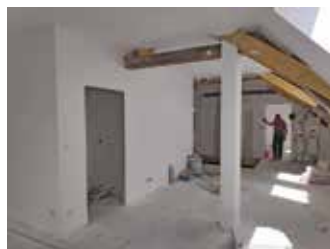
À moitié terminés, les travaux permettaient d'imaginer de quoi le logement allait avoir l'air.
